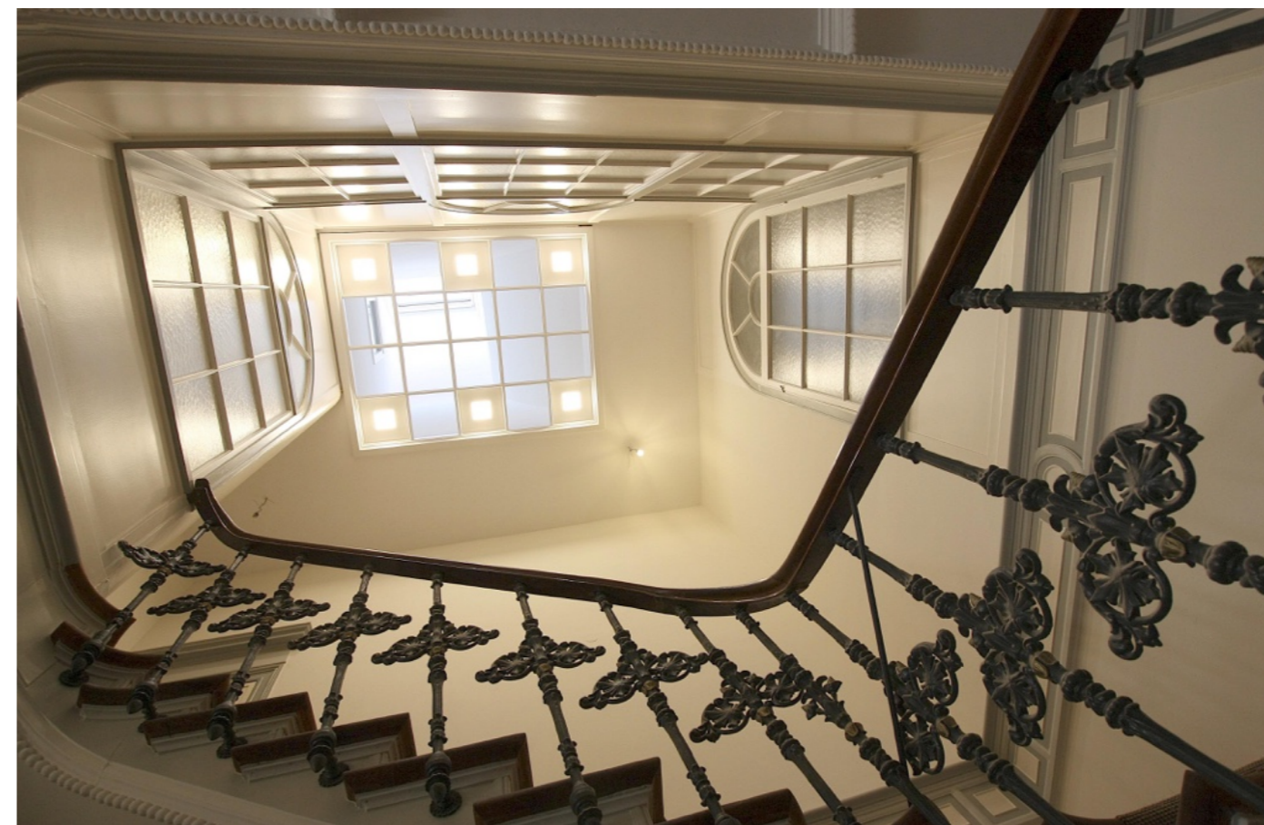
Oberlicht im Treppenhaus des Vorderhauses nach Sanierung
