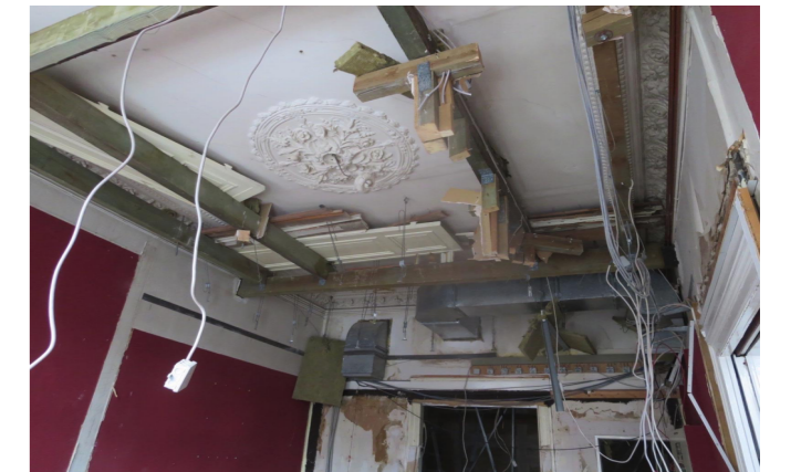
Obergeschoss im Vorderhaus vor Sanierung
