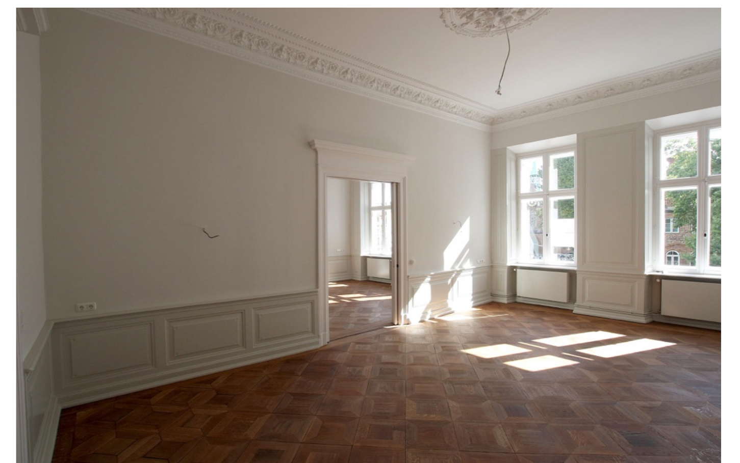
Obergeschoss im Vorderhaus nach Sanierung
