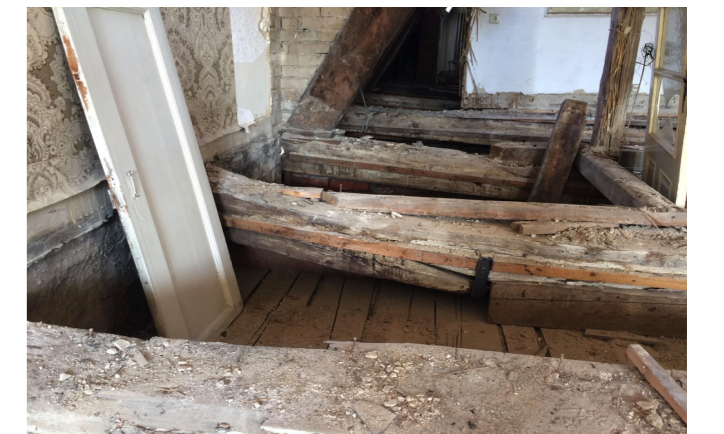
Dachgeschoss im Vorderhaus vor Sanierung
